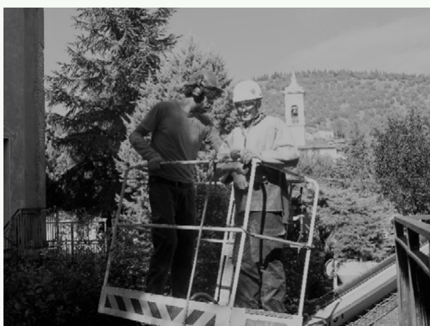
Le prime attività di manutenzione del verde
